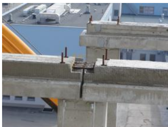
Obr. 8 – Detail spoje průvlaků
