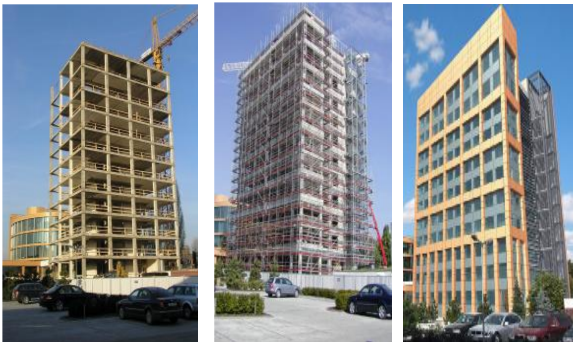
Obr. 2 –demolice, montáž OP, finální pohled
