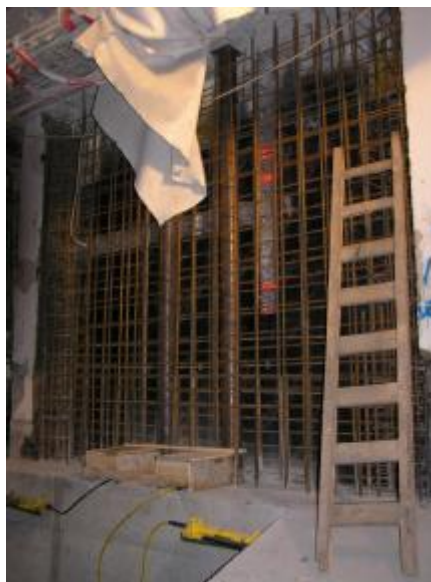
Obr. 5 – Aktivace ztužující stěny
