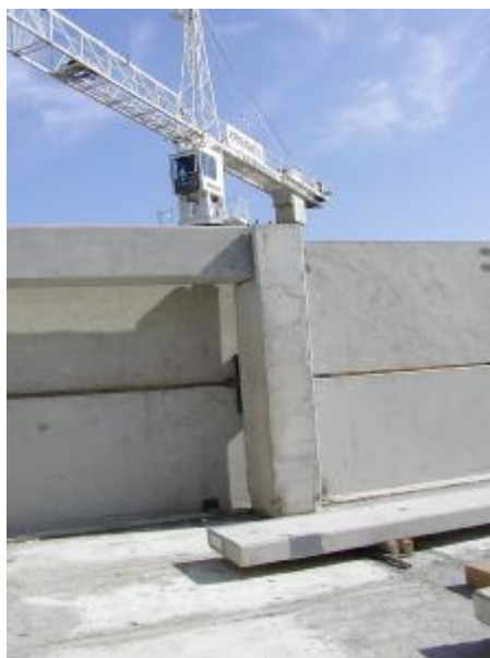
Obr. 7 – Montáž atik
