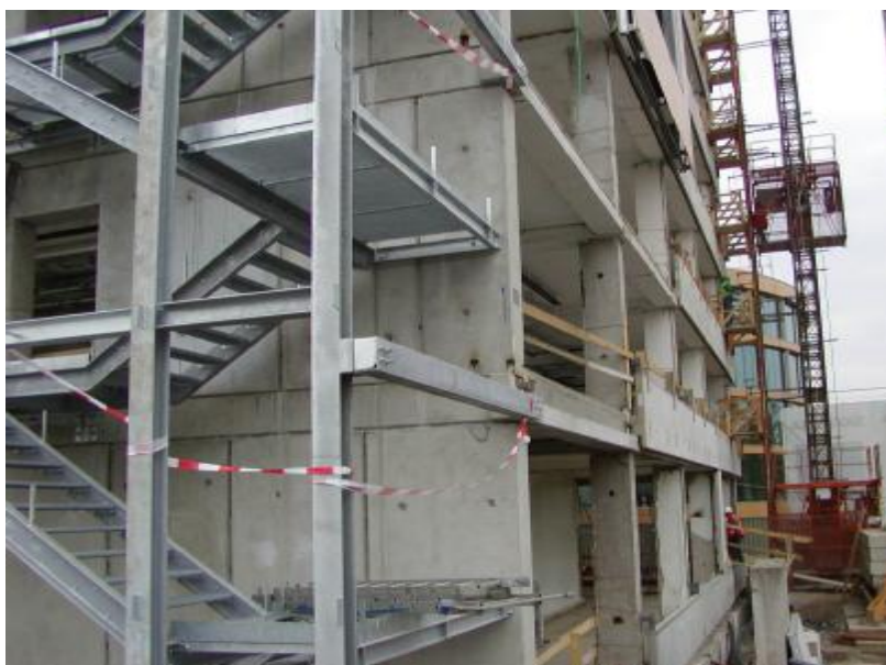
Obr. 9 – Montáž ocelové přístavby a ž.b. pláště
