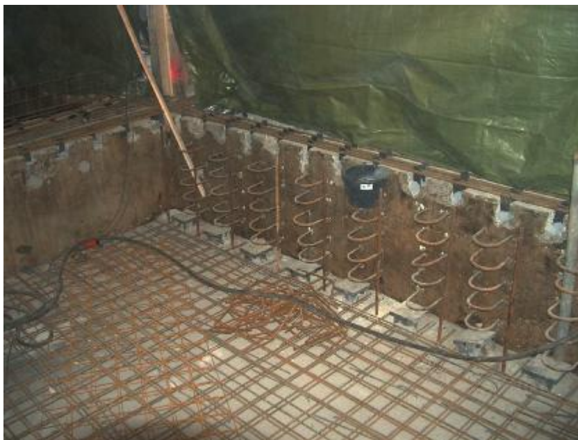
Obr. 3 – zesílení základů nabetonováním a mikropilitami
