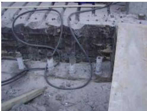
Obr. 9 – Hlavy mikropilot
