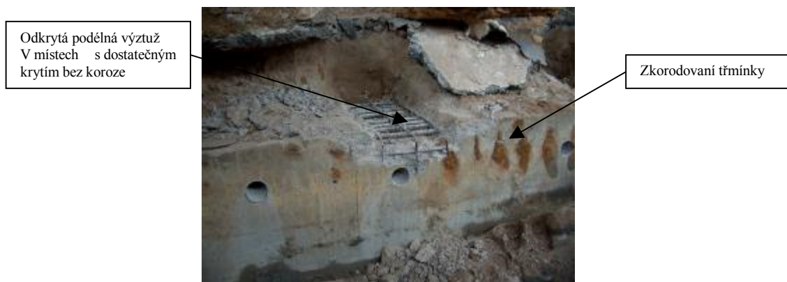
Obr. 6 – Stav základů po odkrytí
