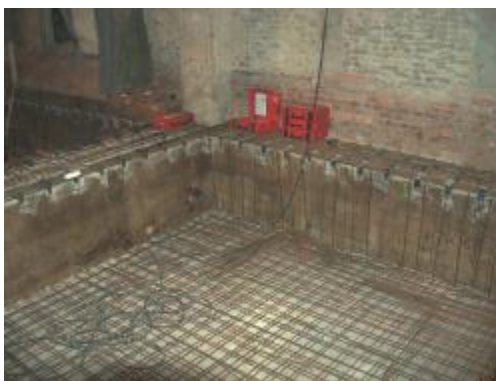
Obr. 7 – Výztuž nabetonávky
