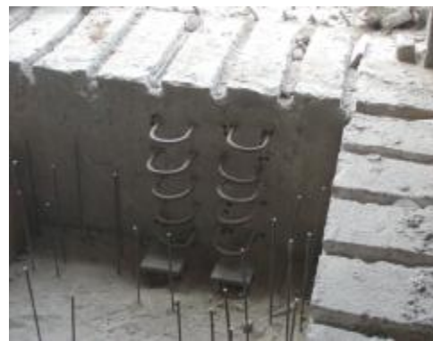
Obr. 8 -kotvení hlav mikropilot
